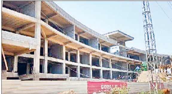
अंबाला शहर के नागरिक अस्पताल के नए भवन का निर्माण भी नए साल में पूरा होने की संभावना है। इस अस्पताल का अपग्रेड कर 300 बैड किया जाएगा। इसकी मंजूरी मिलने के बाद नए भवन का निर्माण भी शुरू हो चुका है। हालांकि पिछले कुछ महीने से यह काम लटका हुआ है। इस योजना के निर्माण पर 64.71 करोड़ रुपये की मंजूरी मिल चुकी है। 300 बैड का अस्पताल बनने के बाद जिला के लोगों को राहत मिलेगी। यहां हर प्रकार की सुविधाएं उपलब्ध होंगी। अस्पताल में अत्याधुनिक मशीनें मुहैया करवाई जाएंगी ताकि रोगियों को बेहतर उपचार मिल सके। पिछले काफी समय से इस अस्पताल को अपग्रेड करने की बात हो रही थी। दरअसल अंबाला शहर नागरिक अस्पताल में हर रोज हजारों मरीज जांच के लिए आते हैं। यहां पंजाब एरिया के मरीज भी बड़ी संख्या में उपचार के लिए आते हैं। ऐसे में अब इस अस्पताल के नए साल पर अपग्रेड होने से मरीजों को बड़ी राहत मिलने की बात कही जा रही है।
